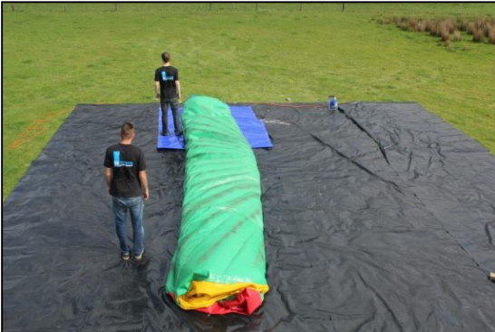
Stap 7: Rol luchtkussens uit in de richting naar voorkant.
