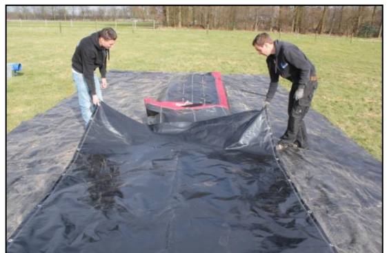
Stap 36: leg de transportzak op het spanbandje tegen het luchtkussen aan. En sla het kussen terug zodat het op de transportzak ligt.
