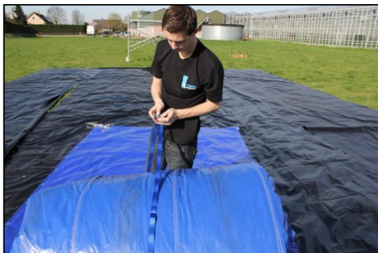
Stap 16: Plaats de spanband om kussen, zodat deze compact blijft.
