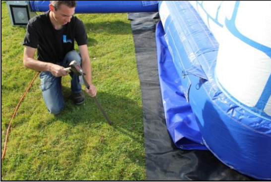
Stap 19: Sla anker schuin van kussen af.
