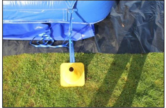
Stap 20: Bevestig spanband aan het anker.
