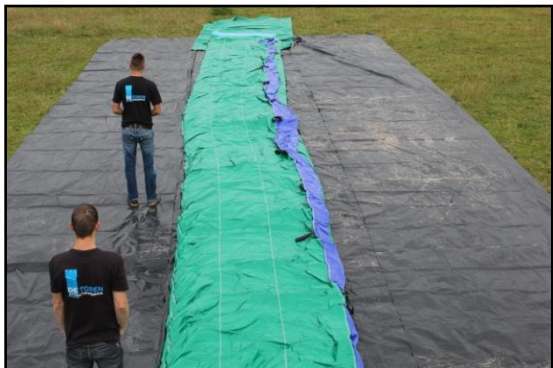
Stap 7: Luchtkussen in een rechte baan trekken.
