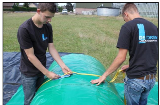
Stap 12: Aan het einde van het oprollen, moet de spanband worden vast gemaakt.
