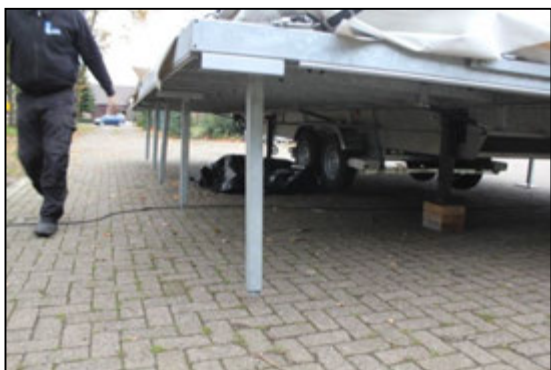
Stap 29: Zet de poten naar beneden die nog niet naar beneden staan.
