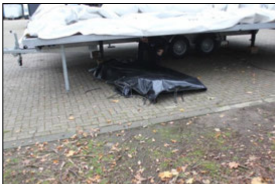
Stap 28: Trek /leg heel dak onder de trailer zodat die niet meer achter het podium uitkomt.
