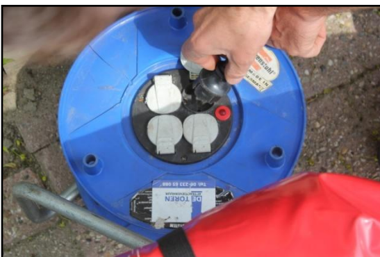
Stap 17: Steek de stekker in de volledig afgerolde en gearde haspel.
